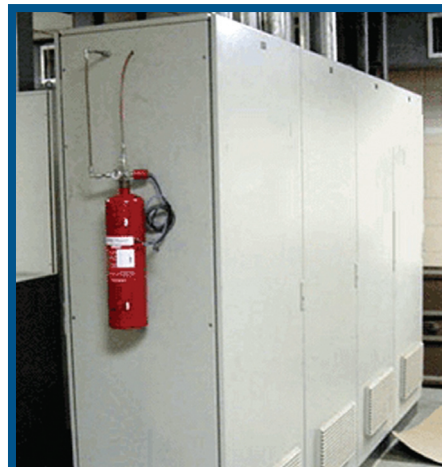
Пример монтажа установки снаружи приборного шкафа
