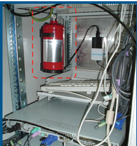
Пример монтажа установки внутри приборного шкафа
